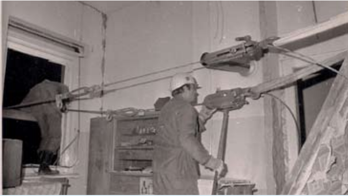
1991 Gebäudesicherung mit Greifzügen nach Gasexplosion im Stadtteil Oberhausen
