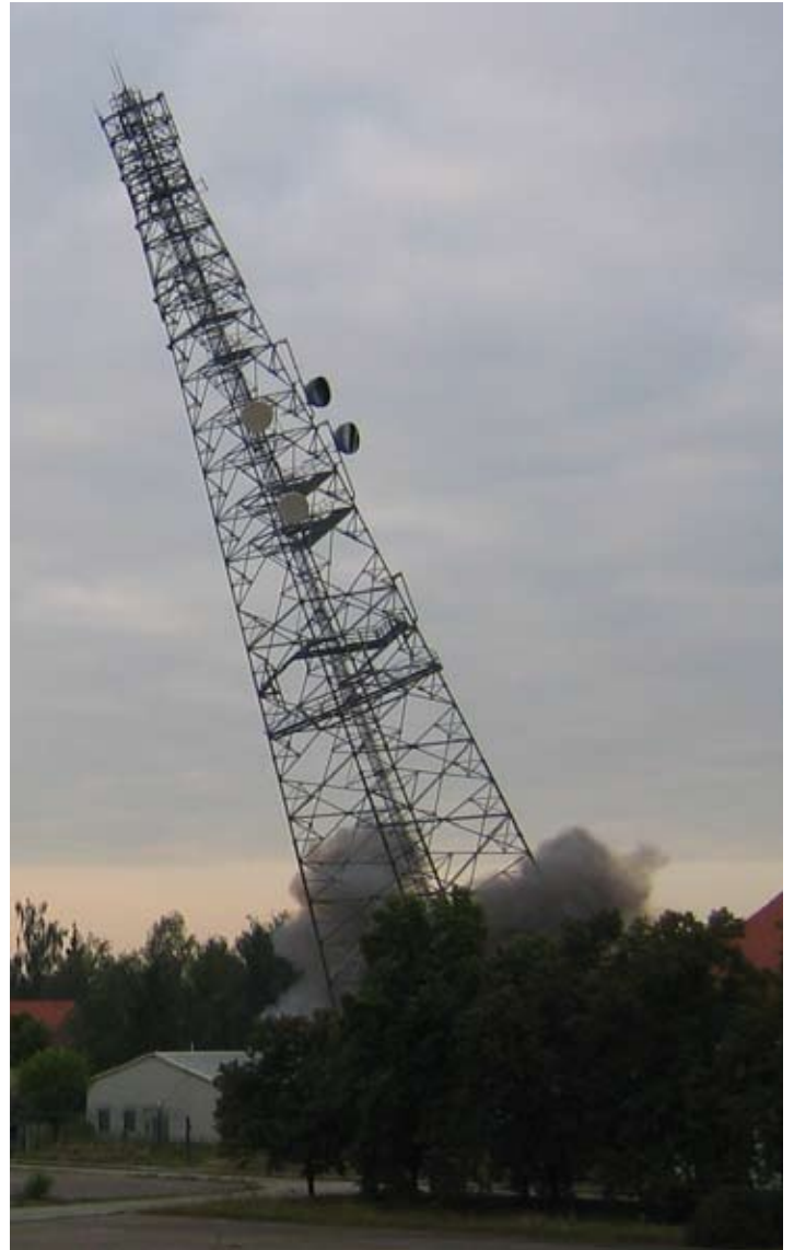
Sprengung Gittermast (82 Meter hoch) ...
