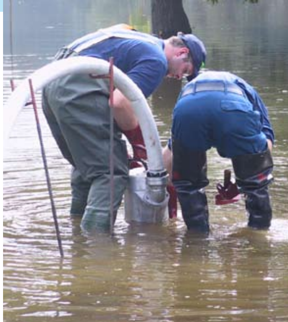
Tauchpumpe im Einsatz
