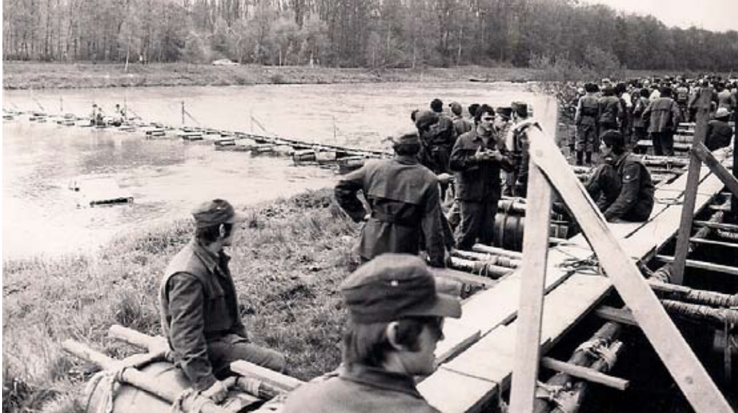
1977 Großübung in Schwaben: Brückenschlag über die Donau
